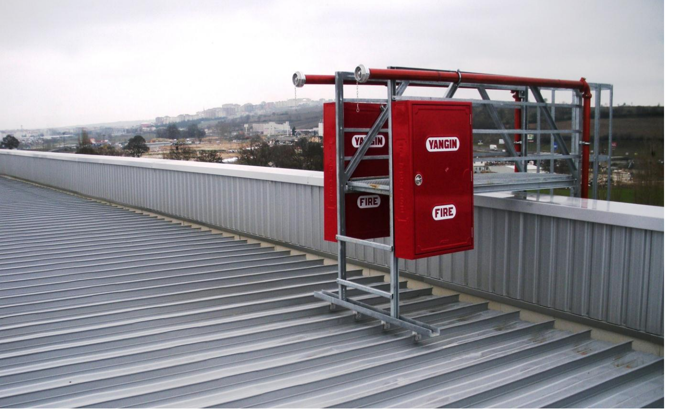
Çatıda merdiven ayak montaj uygulaması
