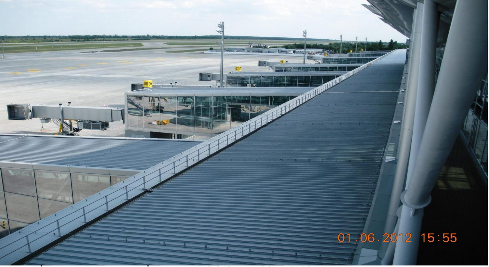
BORYSPİL /KIEV ULUSLAR ARASI HAVA LİMANI / GALERİ BÖLÜMÜ / KASET İÇİ TAŞYÜNÜ ÜZERİ 65/310 KENETLİ PANEL
